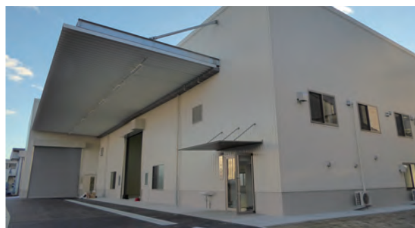
試験体製作棟
