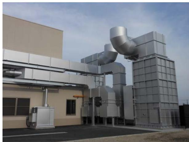
写真-2 排煙処理装置 (2 基)
