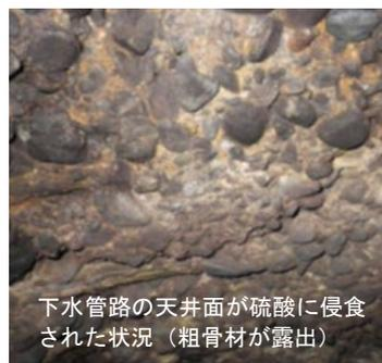
下水管路の天井面が硫酸に侵食された状況（粗骨材が露出）
