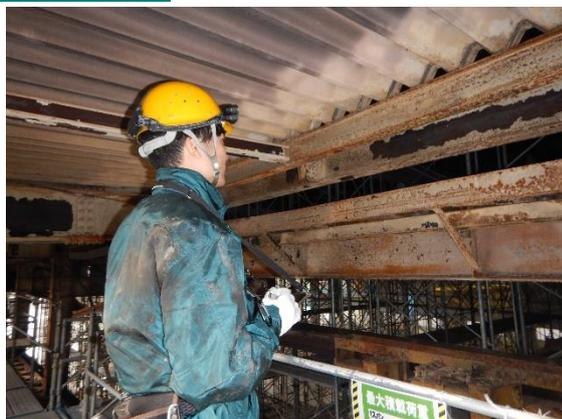
構造部材の被災状況を目視で確認します。鉄骨造建築物においては、鉄骨表面の塗料の被災状況などから部材のおおよその受熱温度を推定し、二次調査を実施する範囲を決定します。また、鉄骨造は、鉄筋コンクリート造に比べて熱により部材が変形しやすく、火災や煙がまわっていない箇所においても火災の影響が出ている可能性があるため、建築物全体にわたって目視観察を行います。
