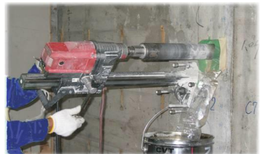
コンクリートコアの切り取り状況
