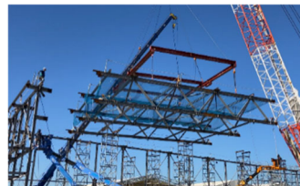
写真-5 屋根鉄骨取付状況
