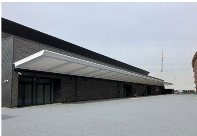
写真-2 建物外観（東側）
