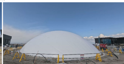
炭酸化養生用ダクト接続
