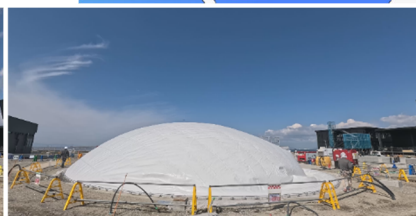
図-4 環境配慮型コンクリートの吹付け
