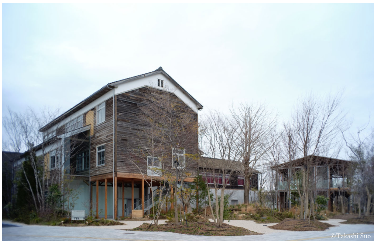
いのちパーク側からの外観
