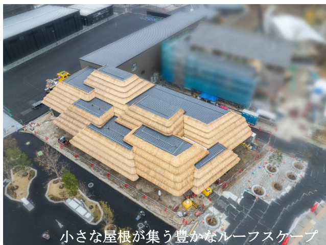
約5m跳ね出した茅屋根で作る軒下空間
