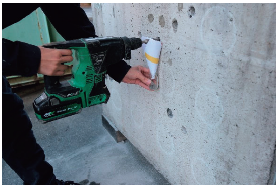
写真-2 振動ドリルによる削孔状況
