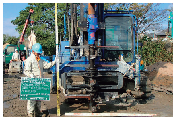
写真-1 上部吐出弁ユニットを装着した攪拌装置例
