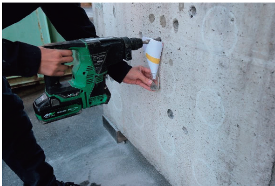
写真-2 振動ドリルによる削孔状況
