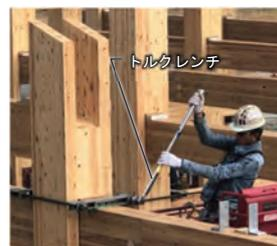
写真-3 貫接合部の施工状況
