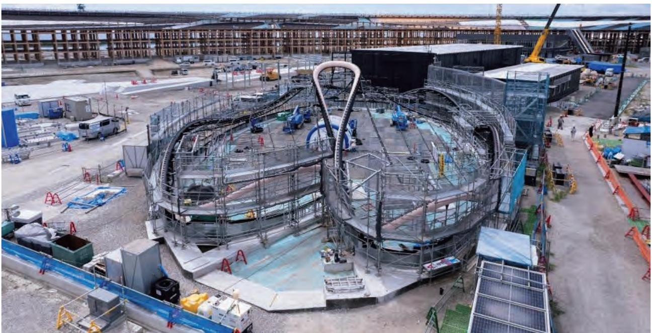
写真-3 シグネチャーパビリオン「いのち動的平衡館」ケーブル緊張時
