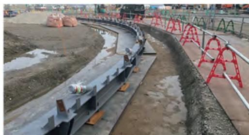
写真-1 鉄骨基礎 施工状況
