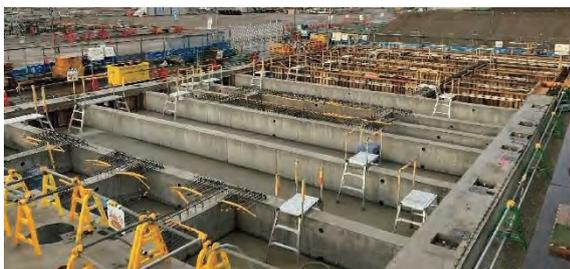
写真-5 1階床鋼製床敷設前の状況
