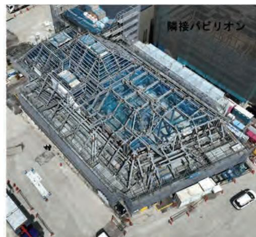
写真-4 南側鉄骨建て方時の空撮
