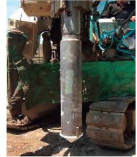
写真-2 芯部築造用先端ビット
