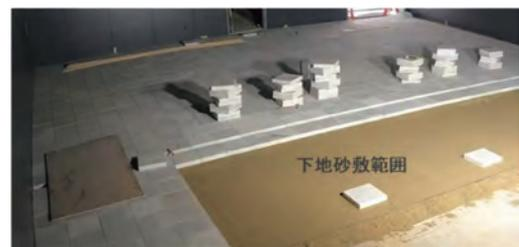
写真-10 T-e Concrete® コンクリート平板敷設時の状況
