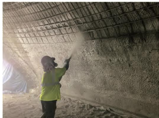
写真-6 ECMコンクリート<sup>®</sup>吹付けによるサステナドーム躯体の構築
