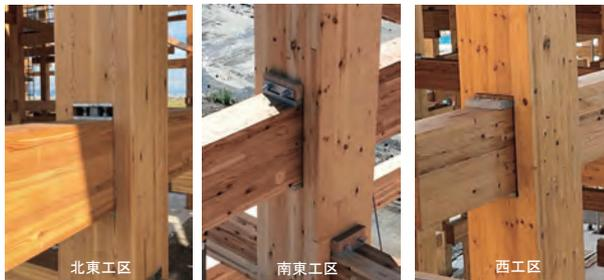
写真-6 3工区の貫接合部の外観
