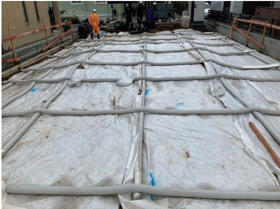
写真-1 モルタル打設後
