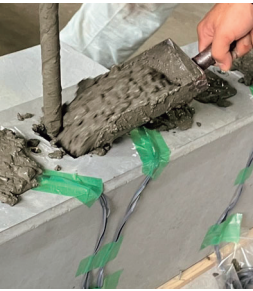
図-4 コンクリート打設
