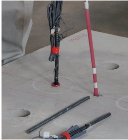
図-2 樹脂の注入
