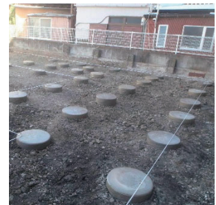
写真-4 施工後全景
