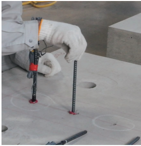
図-3 アンカー筋挿入
