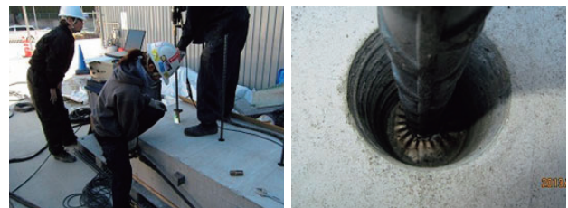
スタッド溶接状況
