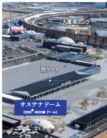
写真-1 CUCO ® -SUICOMドーム位置
