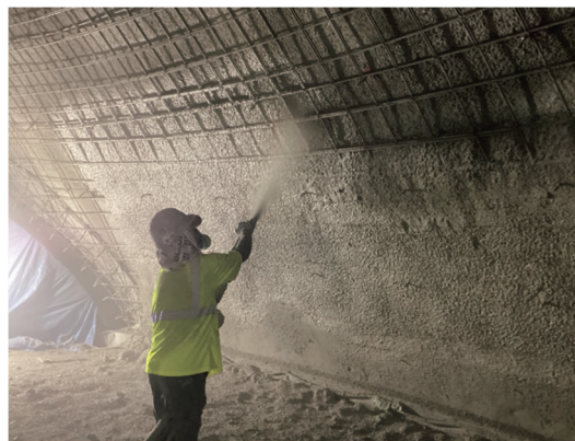
写真-6 ECMコンクリート®吹付けによるサステナドーム躯体の構築
