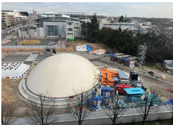
写真-4 試施工ドーム建築物（東京都調布市：飛田給ドーム）
