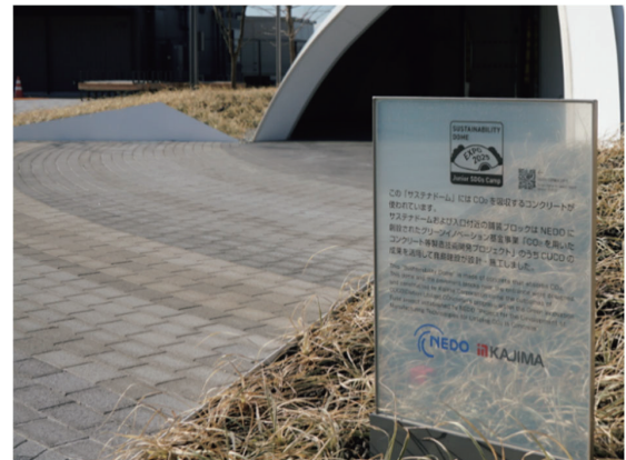
写真-8 CUCO®-SUICOMドーム外構の環境配慮型ILBブロック
