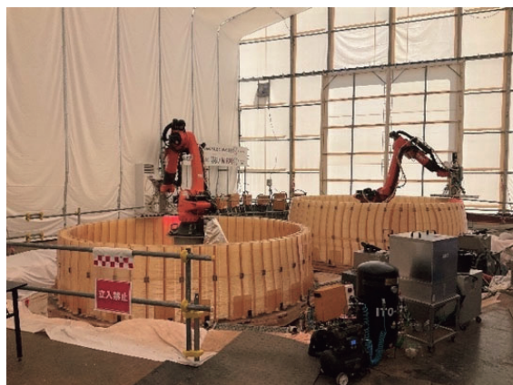
写真-10 大型3Dプリンターによる施工状況
