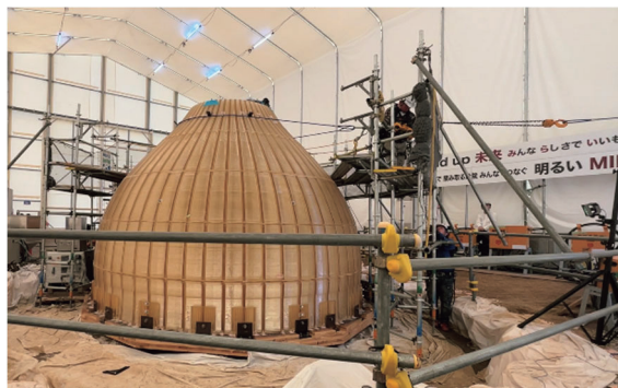
写真-11 出力後の実大加力試験状況
