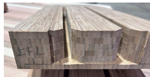
写真-7 スリット加工-2
