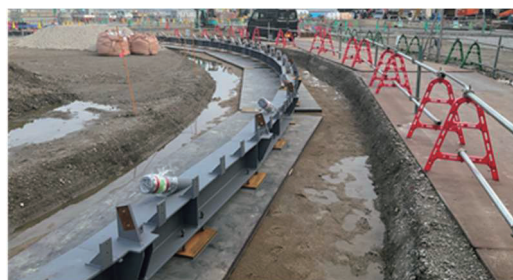
写真-1 鉄骨基礎 施工状況
