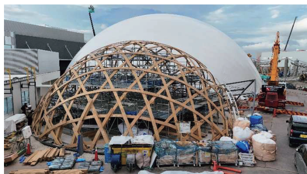
写真-18 竹集成材ドーム建方中
