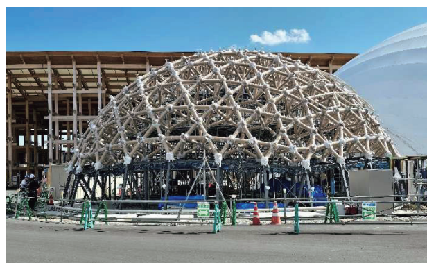
写真-17 紙管ドーム建方中
