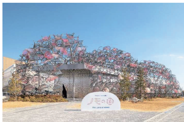
写真-1 建物全景（昼景）
