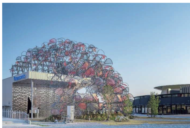
写真-3 ファサード（北面）
