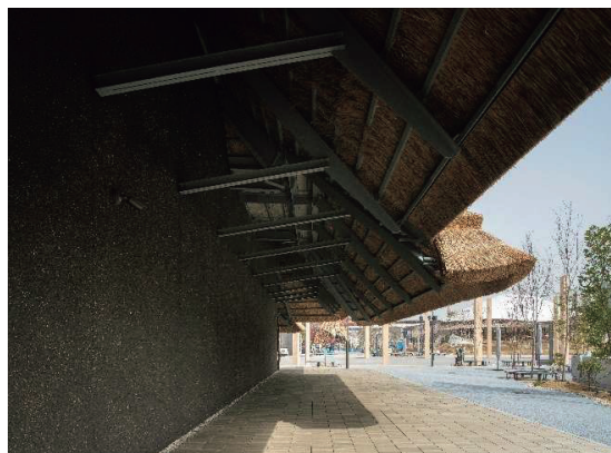
写真-3 鉄骨架構による軒の出が大きな茅葺屋根底
