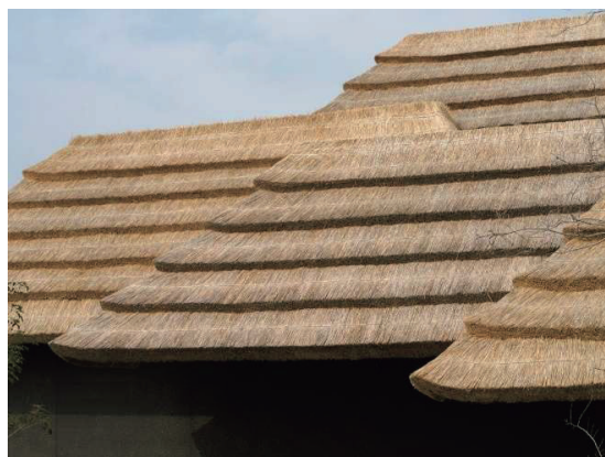
写真-2 段葺工法による茅葺屋根
