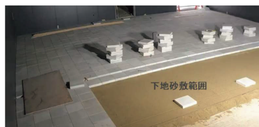
写真-10 T-e Concrete® コンクリート平板敷設時の状況
