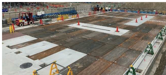
写真-6 1階床鋼製床敷設後の状況
