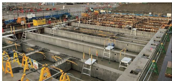
写真-5 1階床鋼製床敷設前の状況
