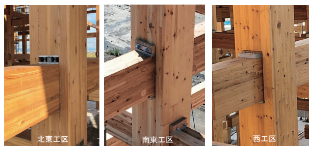
写真-6 3工区の貫接合部の外観
