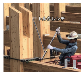
写真-3 貫接合部の施工状況
