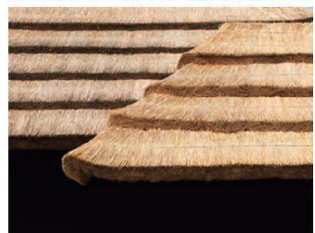
今回の建物では加工の少ない段葺工法を採用しています。段葺を採用することで解体後の転用が容易になり、仮設建築物にふさわしい工法と考えます。各屋根は5つの産地から茅材を調達しています。産地の植生環境の違いにより茅のサイズや色味が変化し屋根毎に異なる表情を見せます。更にモックアップを製作し色味の変化の確認や止水性能の確認を行いました。
