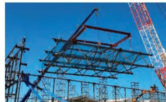
写真-5 屋根鉄骨取付状況
