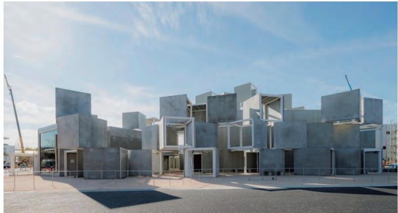
真水資源の大量消費に対する新しい取組みとして、塩害耐性が強くセメント使用量を削減できる海水練りコンクリートパネルを開発。100%大阪湾の海水での打設を行い真水資源の保全を体現したファサードが実現した。
