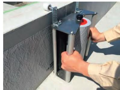
図-2 基礎高耐久化シート用施工治具
