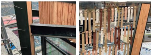
ワイヤーに取り付けられた短冊状テント素材の「ひらひら」
