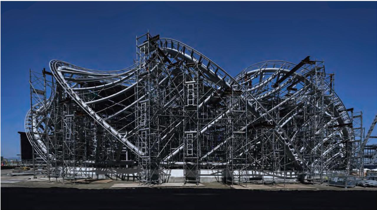
写真-3 曲げ加工鋼管を用いた「斜めアーチ千本格子構造」(鉄骨建方中)
