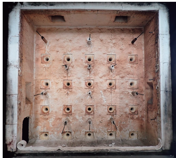
写真-1 大型壁炉 (Part 3,4対応)
