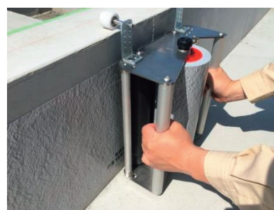
図-2 基礎高耐久化シート用施工道具
