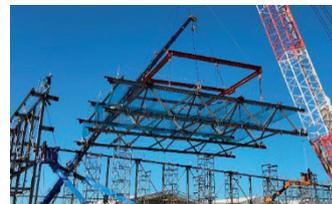
写真-5 屋根鉄骨取付状況
