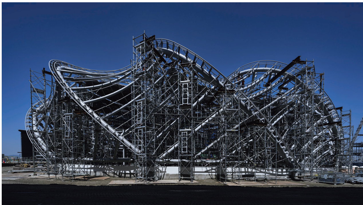
写真-3 曲げ加工鋼管を用いた「斜めアーチ千本格子構造」(鉄骨建方中)
