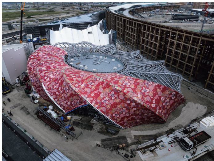
写真-2 鉄と膜による造形美 (西陣織膜施工中)
