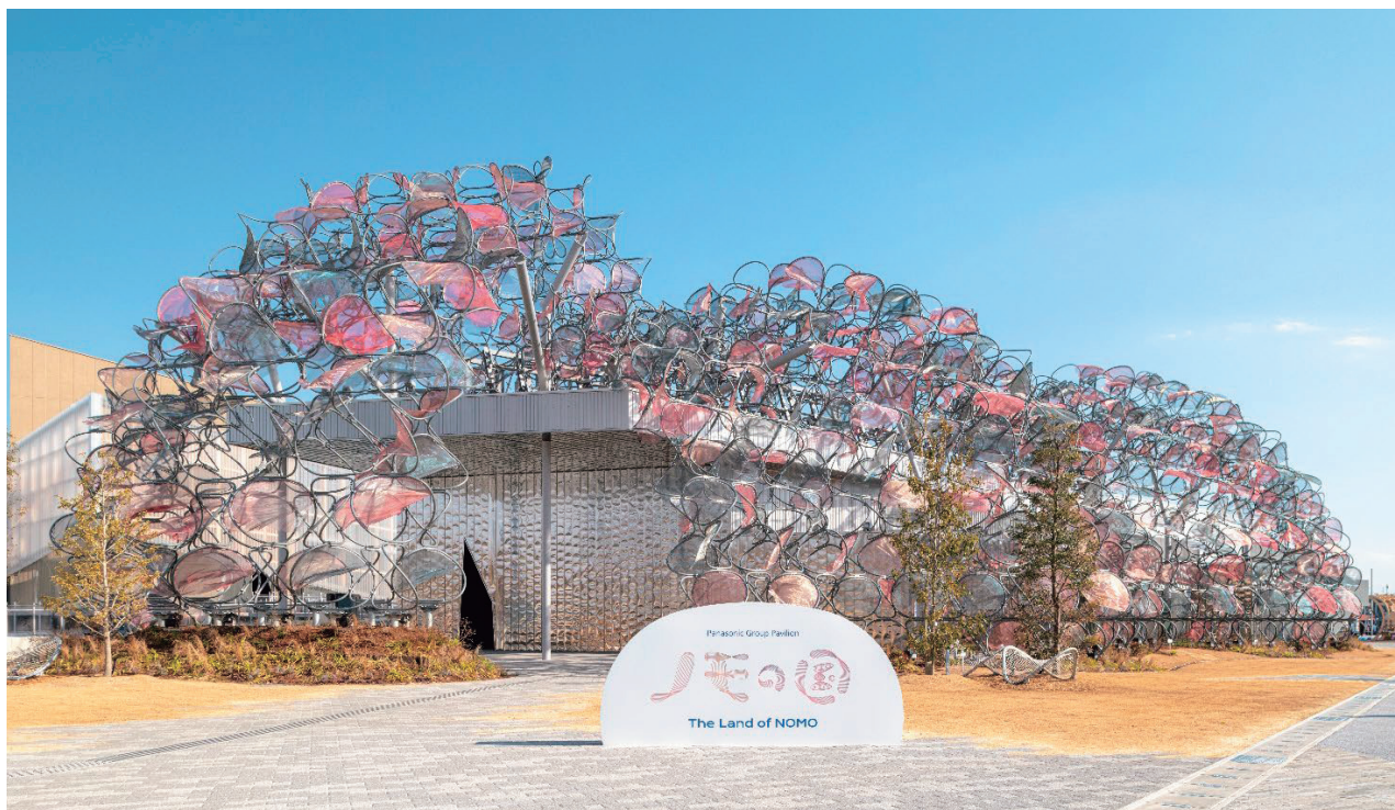
図-1 全景（北西より建物を望む）
