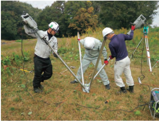
写真-2 施工状況
