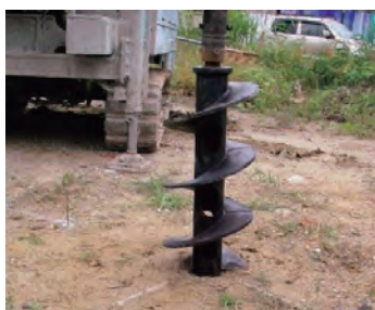
写真-1 オーガー掘削
