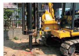
写真-2 施工状況
