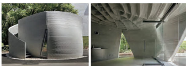
図-10 3Dプリンター実証棟「3dpod」 10)
