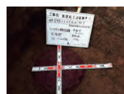
(ii) 拡径部出来形確認
