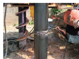
写真-4 補強材の接続
