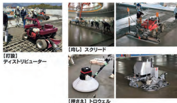
写真-5 コンクリート施工効率化のためのロボットやシステム
