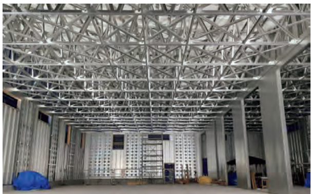
図-16 屋内空間（工事中）
