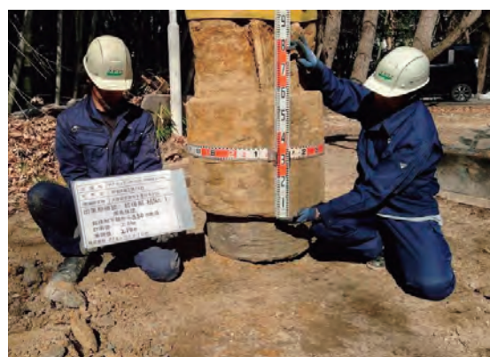
写真-2 築造した改良体の一例
