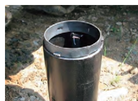
写真-3 継ぎ手治具の取り付け
