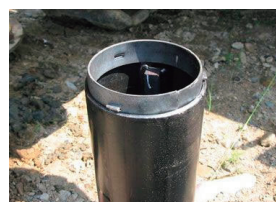
写真-3 継ぎ手治具の取り付け
