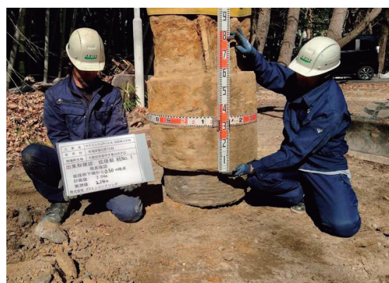
写真-2 築造した改良体の一例
