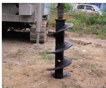
写真-1 オーガー掘削
