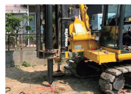
写真-2 施工状況
