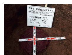
(ii) 拡径部出来形確認
