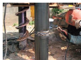
写真-4 補強材の接続
