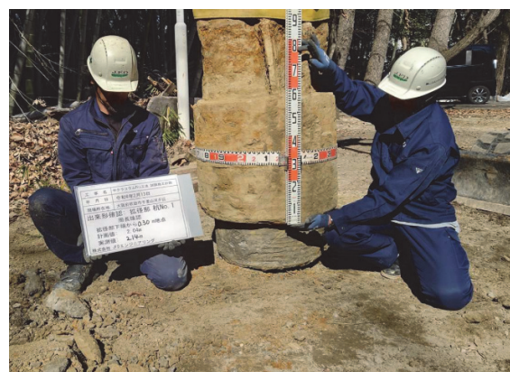
写真-1 築造した拡張部の一例
