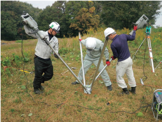
写真-2 施工状況
