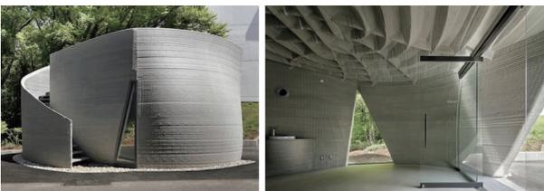
図-10 3Dプリンター実証棟「3dpod」<sup>10)</sup>
