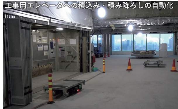
写真-2 搬送ロボットと工事用エレベータ
