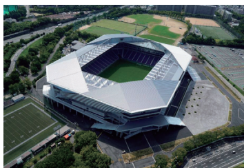
吹田サッカースタジアム 1)
