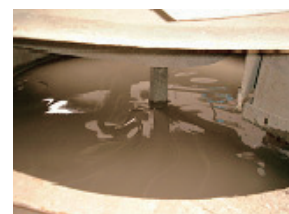
写真-3 セメントスラリー製造
