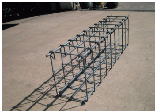
写真-2 現場組立ユニット
