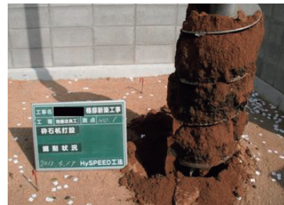
写真-1 土質確認状況
