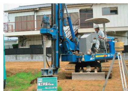
写真-1 施工状況
