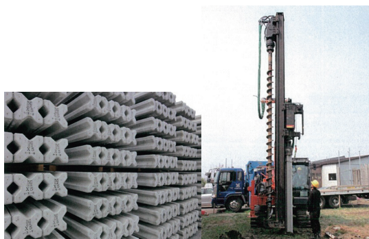
写真-1 補強材および施工状況
