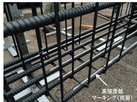
写真-1 ダブルスタークの配筋例
