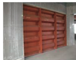
波形鋼板耐震壁の設置状況
