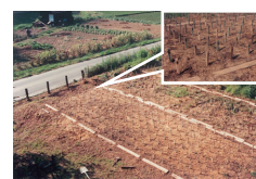
写真-3 耐久性試験状況
