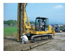
写真-2 施工状況
