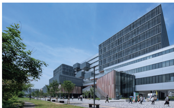
写真-1 H棟 建物外観
