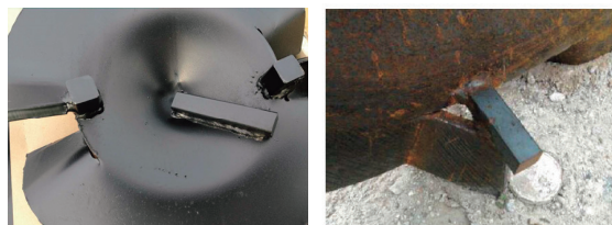
写真-1 翼部補強材
