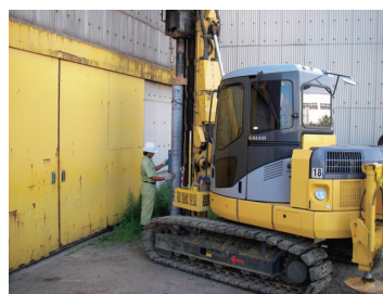
写真-3 構造物に接近した施工
