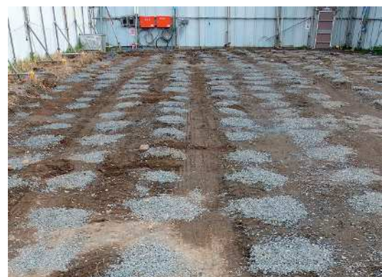
図-3 打設した碎石パイル
