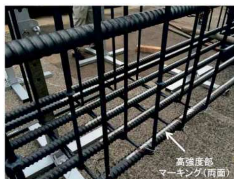
写真-1 ダブルスタークの配筋例
