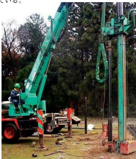
写真-1 施工状況
