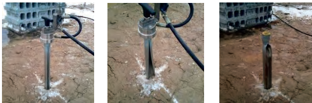
《拡張前》 《拡張中》 《拡張完了》 写真-1 拡張状況写真
