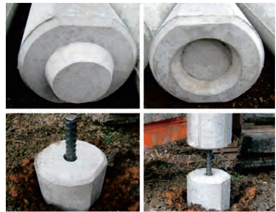
写真-1 補強材および施工状況
