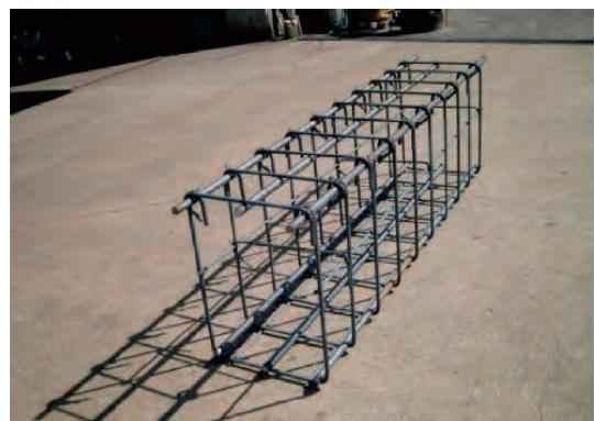
写真-2 現場組立ユニット
