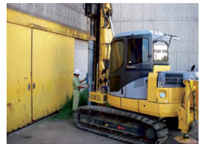
写真-3 構造物に接近した施工
