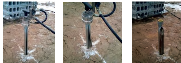
《拡張前》 《拡張中》 《拡張完了》 写真-4 拡張状況写真
