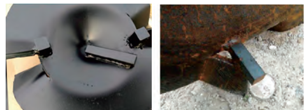
写真-1 翼部補強材
