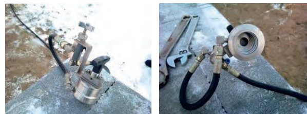
写真-3 拡張鋼管の加圧装置
