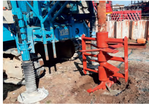
写真-1 MSコラム・E工法の攪拌機
