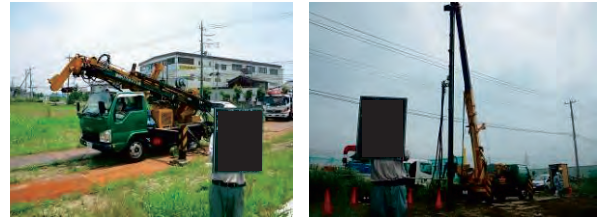
写真-2 施工状況
