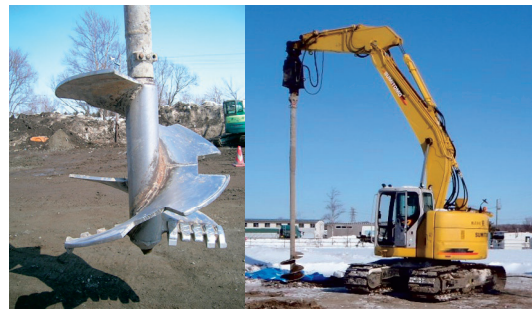
写真-1 TSヘッド 写真-2 施工機
