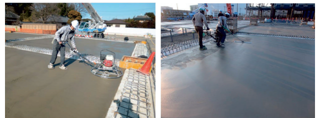
写真-1 コンクリート床部材の仕上げ作業状況 (左：2次仕上げ、右：最終仕上げ)
