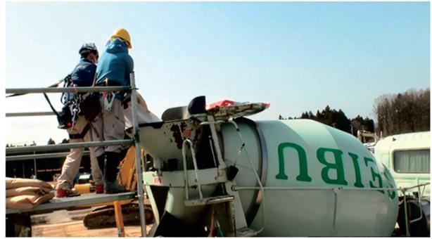
写真-4 建築構造床の施工に適用したACF-Wの投入状況
