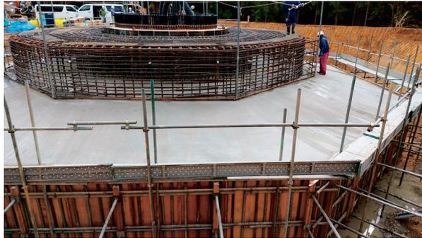
写真-3 施工翌日の仕上げ面の外観
