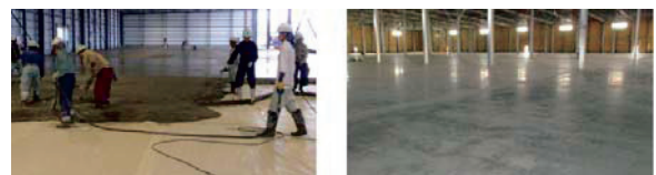
写真-2 土間床施工状況
