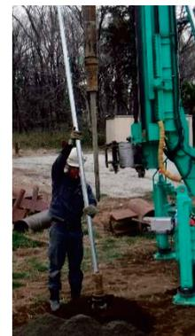
図-4 細径鋼管の挿入状況
