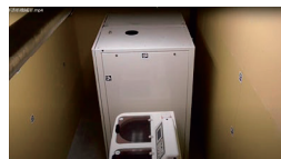
透析機器が大きく移動し、カバーが脱落
