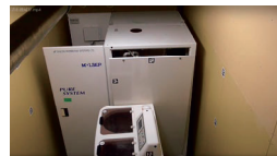
透析機器が大きく移動し、カバーが脱落
