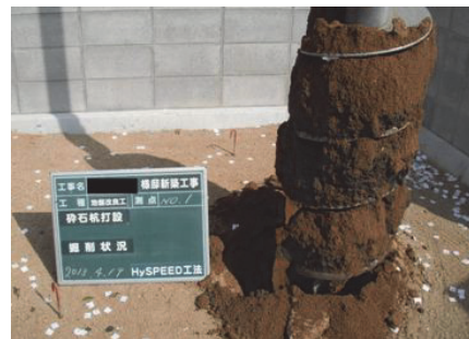
写真-1 土質確認状況
