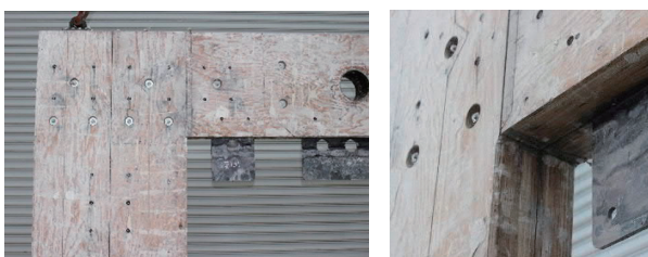
写真-2 加熱実験後の状況
