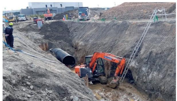
写真-4 その3工事 工事現場(雨水管理設工事)
