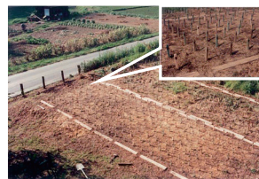
写真-3 耐久性試験状況
