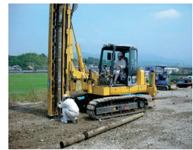
写真-2 施工状況
