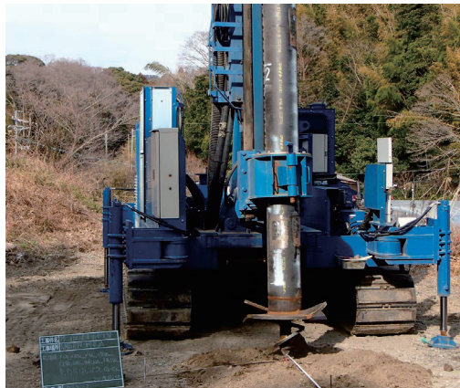
写真-1 杭の施工状況
