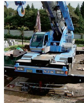
写真-2 載荷試験状況
