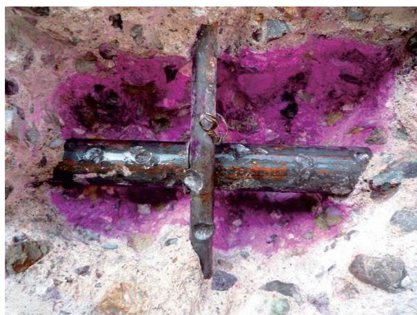
写真-1 中性化が到達しても腐食が進んでいない鉄筋（かぶり厚さ：約30mm（縦筋）、中性化深さ：約40mm）
