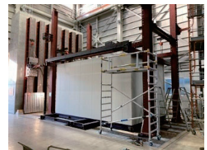
写真-4 組立完了
