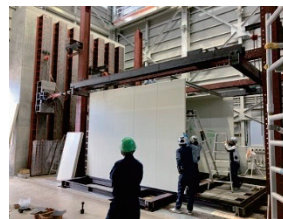
写真-3 壁・天井パネル組立
