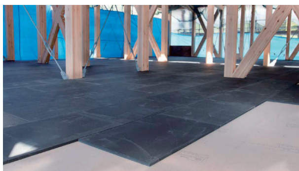
図-19 木造小学校への当社「遮音マット」採用事例
