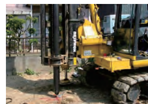
写真-2 施工状況
