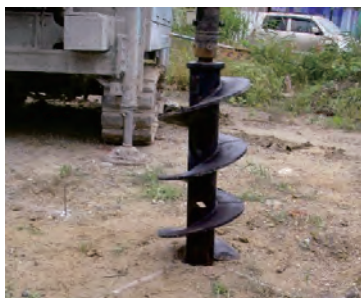
写真-1 オーガー掘削
