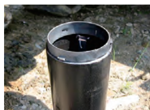
写真-3 継ぎ手治具の取り付け
