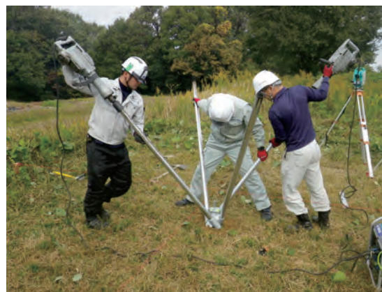
写真-2 施工状況
