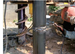
写真-4 補強材の接続
