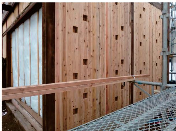
写真-2 壁柱工法の施工 (ハナレギャラリー東側部分)
