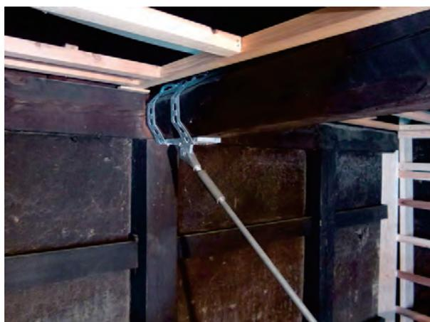
写真-5 スチールブレースによる補強
