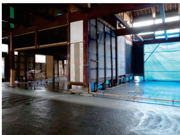
写真-6 玉石基礎のコンクリート補強
