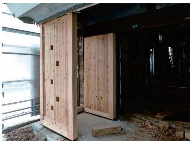
写真-3 壁柱工法の施工 (ファサード北側部分)
