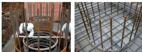
写真-1 拡頭リングの設置状況
