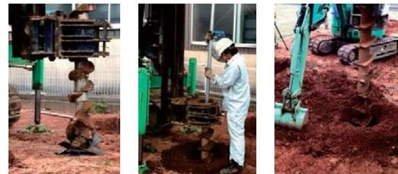
(i) 設置 (ii) 細径鋼管接続 (iii) 締め
