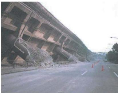
写真-2 阪神高速神戸線の高架橋倒壊（神戸市東灘区）
